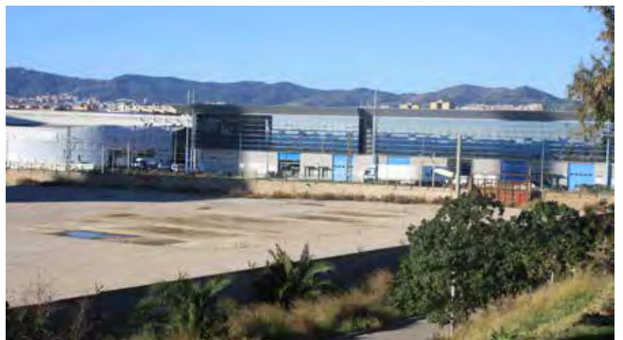
Imagen de la zona del Sector de las Tres Chimeneas en la esquina entre la Avenida Eduard Maristany y la calle de la Mar Negre en Badalona delante de los edificios del proyecto (Nave de Turbinas y Tres Chimeneas). El GIE propone que se centralicen en este espacio las infraestructuras de servicios complementarios del Hub (Fuente GIE)
