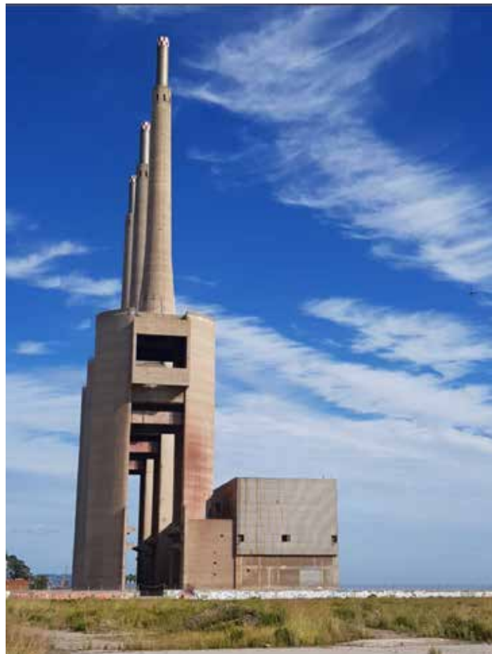
Fuente GIE: Vista de las Tres Chimeneas y el Edificio de Turbinas desde Calle de la Playa Sant Adrià
