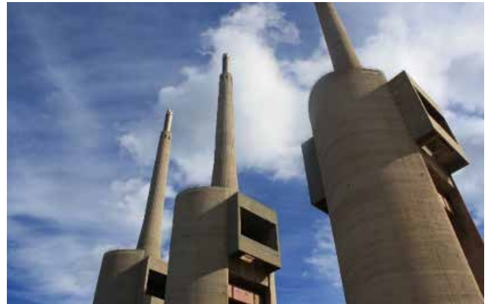
Fuente GIE. Imágenes de los edificios de la CACI de Badalona y de las Tres Chimeneas en Sant Adrià del Besòs.
